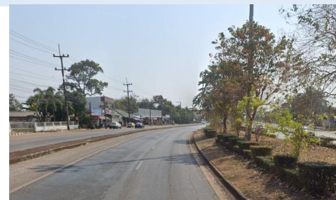
จุดเริ่มต้นโครงการ ทล.22 กม.153+870 (ซ้ายทาง)
