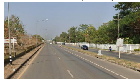
จุดสิ้นสุดโครงการ ทล.2347 กม.1+030 (ซ้ายทาง)
