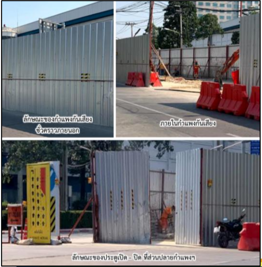
ตัวอย่างกำแพงกันเสียงชั่วคราว ที่ปิดคลุมพื้นที่ก่อสร้างต่อม่อของสะพาน
