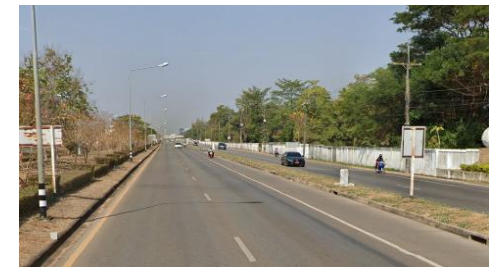
จุดสิ้นสุดโครงการ ทล.2347 กม.1+030 (ซ้ายทาง)
