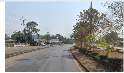
จุดเริ่มต้นโครงการ ทล.22 กม.153+870 (ซ้ายทาง)
